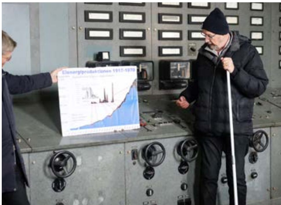
Guiden Harry Frank, Ångkraftverkets Vänner.
