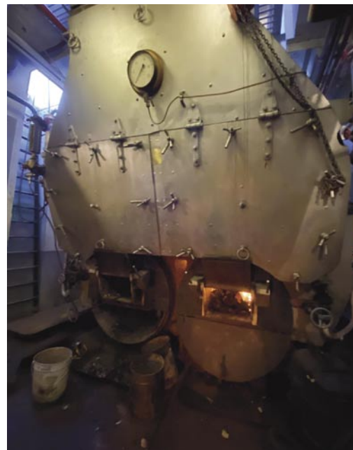
Högt separat pannrum för de två pannorna.
