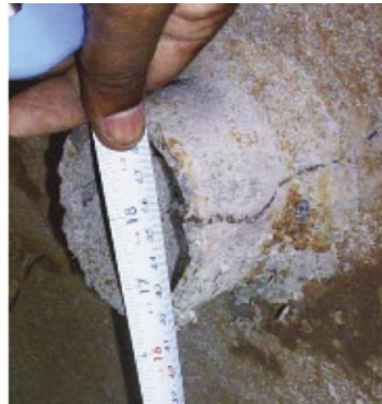
Matarvattenanslutning med spricka orsakad av termiska spänningar. Notera att sprickan vandrat igenom svetsen ut i manteln.
