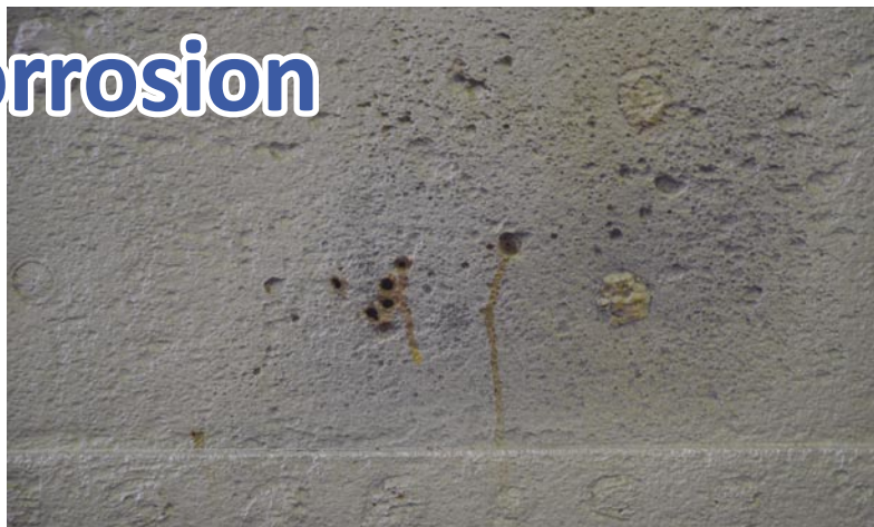
Gropfrätor genom galvanisk korrosion.
