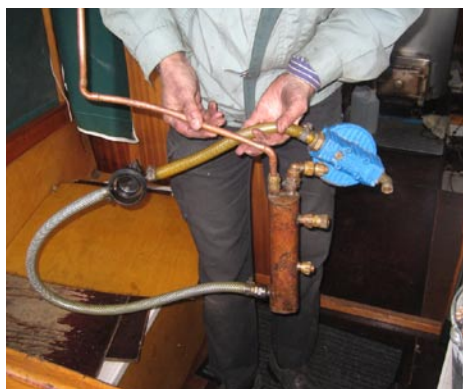
Längst ner i kölen skymtar “brunnen” med luftningsröret och anslutningen till bottenventilen till vänster.
