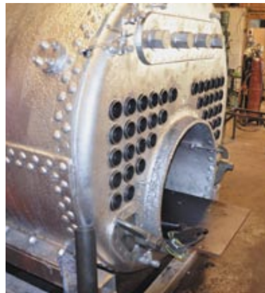
Tuberna är på plats, besiktigt o godkänt.
