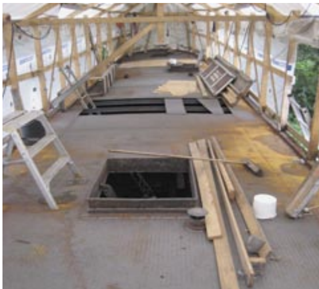
Nytt ståldäck har monterats av Mälarearnas Båtvarv.
